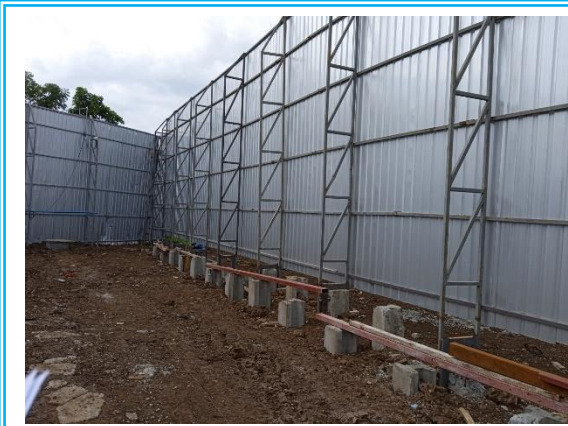
รูปที่ 3.1-1 รั้ว Metal Sheet สูง 6 เมตร
