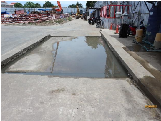
รูปที่ 3.1-7 พื้นที่ทำความสะอาดล้อรถบรรทุก
