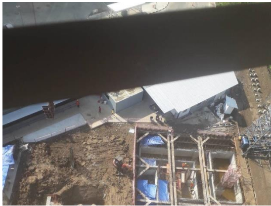
รูปที่ 3.1-15 ติดตั้ง Sheet Pile
