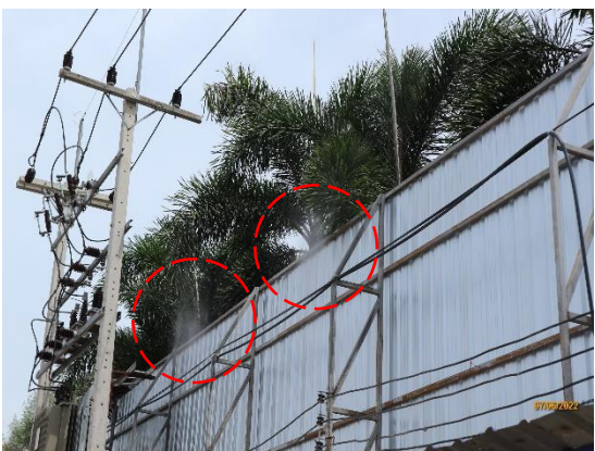
รูปที่ 3.1-11 สปริงเกอร์พรมน้ำกันฝุ่นโดยรอบพื้นที่โครงการ
