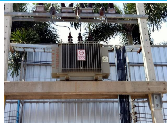
รูปที่ 3.1-34 หม้อแปลงไฟฟ้าในพื้นที่ก่อสร้าง
